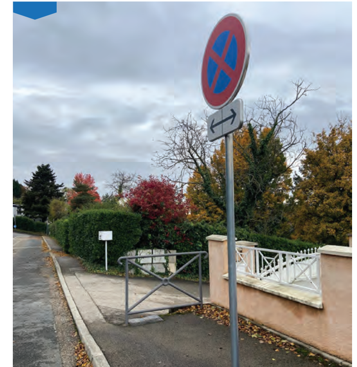
Mise en place d'un panneau d'interdiction de stationner
